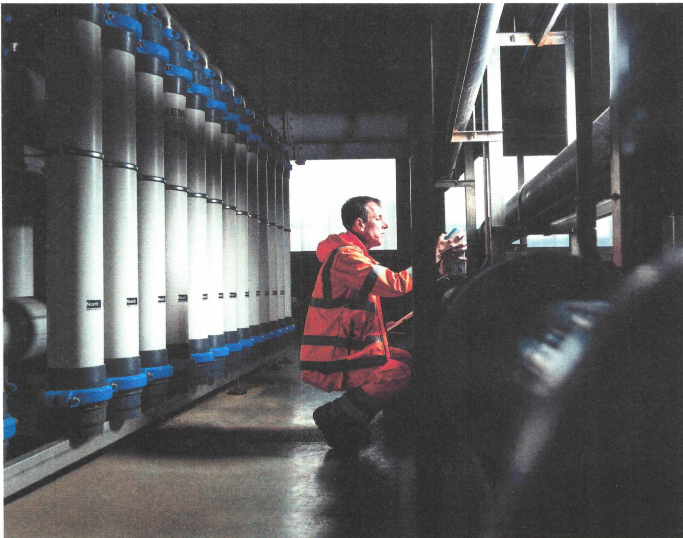
UF-membraansysteem, drinkwaterproductiecentrum De Gavers
